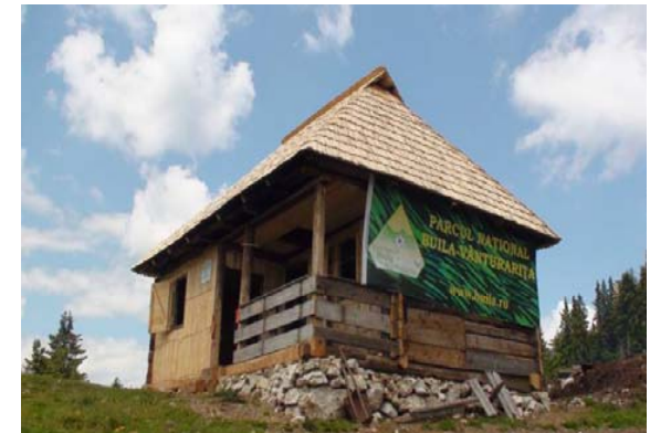
Refugiul Curmătura Builei, reconstruit în Parcul Național Buila-Vânturarița
