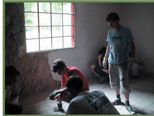
lucrări de reparații în interiorul Cantonului Codric Parcul Național Buila-Vânturarița
