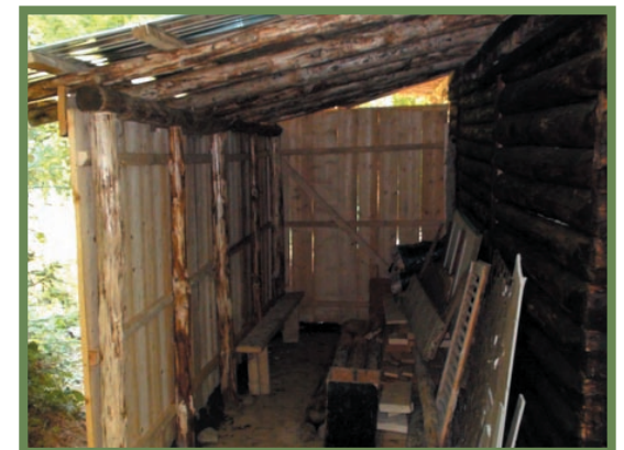
lucrări de reparații și reamenajare Cantonul Codric. Parcul Național Buila-Vânturarița
