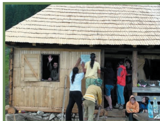
realizarea ultimelor detalii și montarea plăcuței cu mulțumiri
