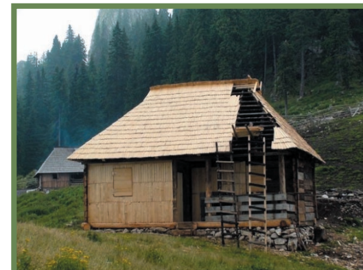
...aproape gata, ultima zi de lucru la acoperiș
