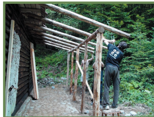
lucrări de reparații și reamenajare Cantonul Codric. Parcul Național Buila-Vânturarița
