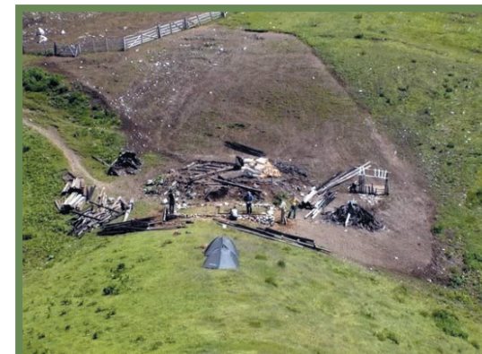
dărâmarea construcției șubrede și păstrarea materialelor încă bune
